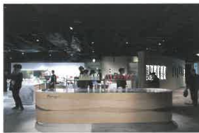
四條河原町で話題の新しい複合ビル「GOOD NATURE STATION」。コスメのお店のディスプレイを施工。「版築」という、砂や粘土などを混ぜたものを型枠の中に流し込み固めて作る。オシャレな空間になじんでいます。
